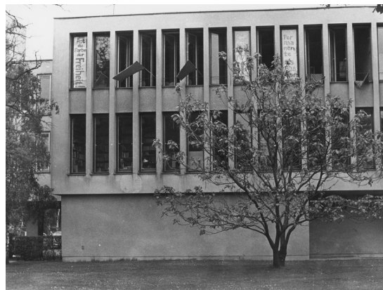
Streik der Publizistikstudenten im Gebäude in der Garystraße (Außenansicht) im Mai 1968, Fotograf: unbekannt / FU Berlin, UA, Foto-Slg., Foto/30916.
