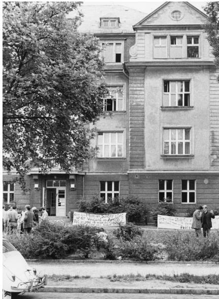
Blick auf das besetzte ehemalige Hauptgebäude in der Boltzmannstraße 3 (Außenansicht), Fotograf: unbekannt / FU Berlin, UA, Foto-Slg., Foto/30911.
